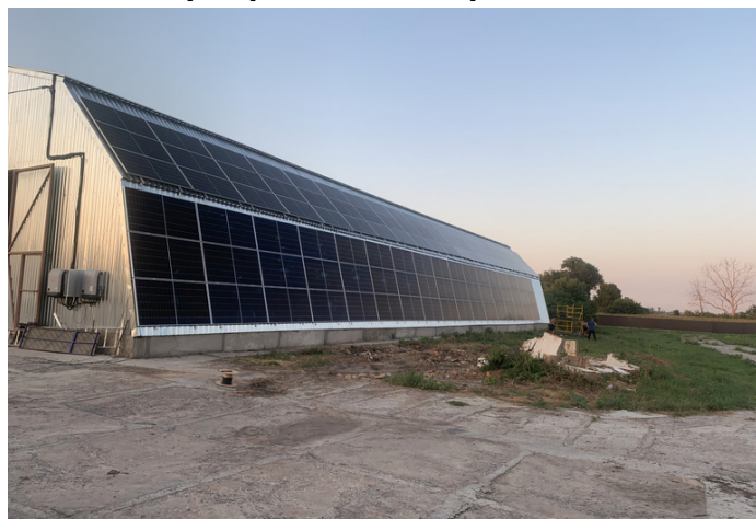
с.Нова Дмитрівка. Станція потужністю 81 кВт. Тваринна ферма
