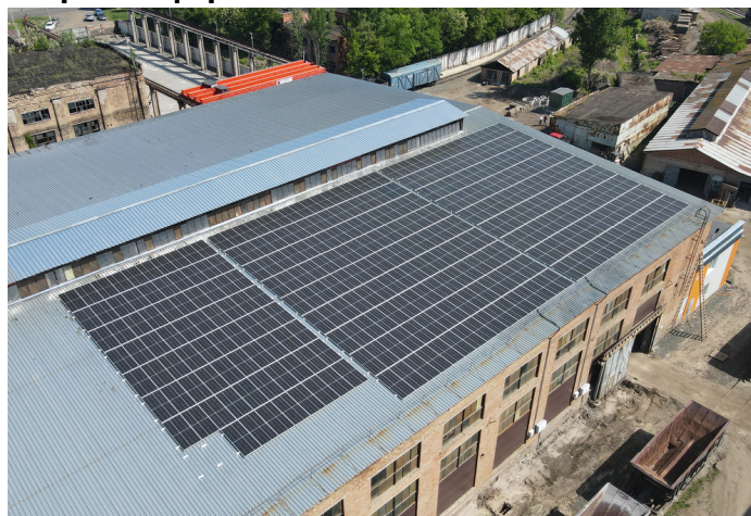
м. Сміла, станція потужністю 200 кВт. Вагоноремонтний завод
